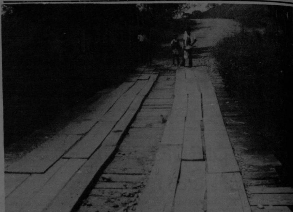
El Instituto de Desarrollo Agrario (IDA) ha construido en el asentamiento campesino El Indio, ubicado en la zona atlántica, 70 kilómetros de caminos, los cuales dan acceso a cada una de las parcelas de los agricultores a una carretera principal. (Calvo)
